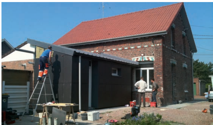
Isolation extérieure d'une extension.
